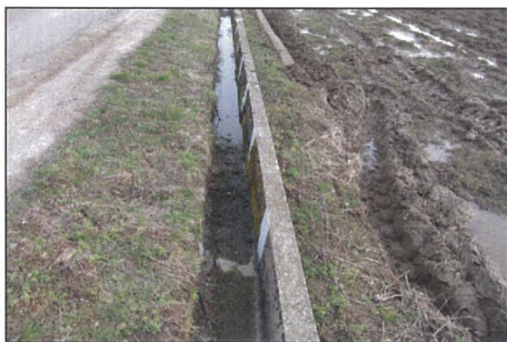
施工後15年の経過状況（天池町）
